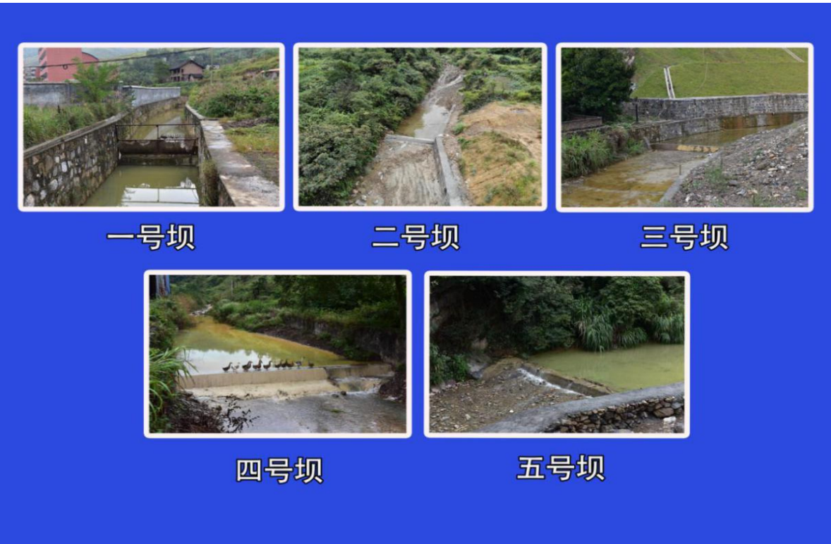
涟溪河截污管网建设工程
