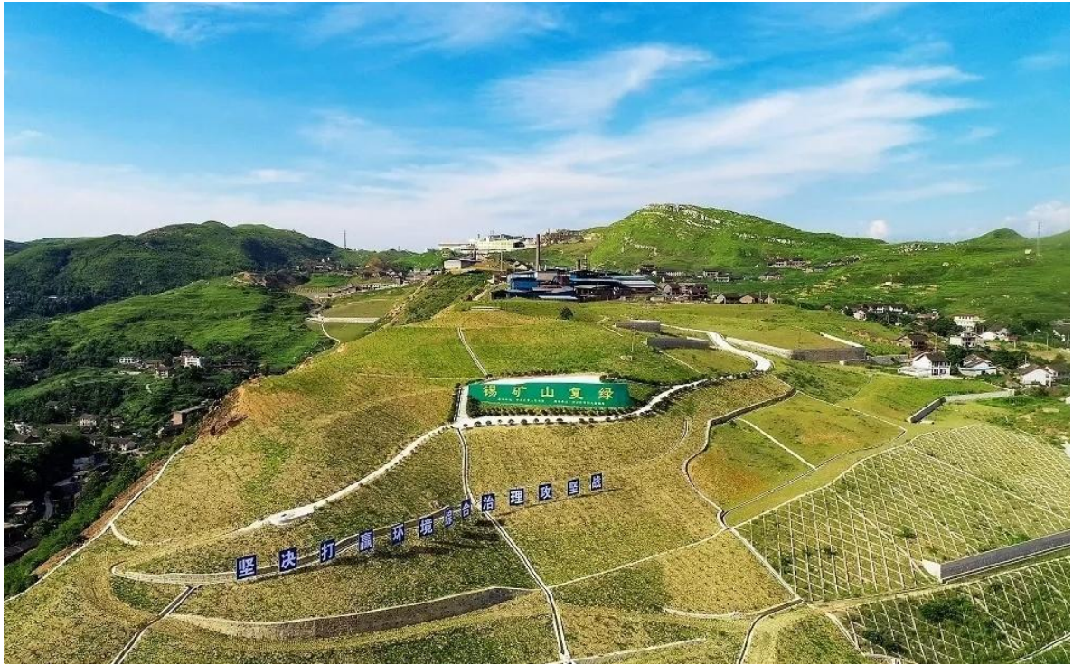
废渣治理、生态修复后的锡矿山远眺
