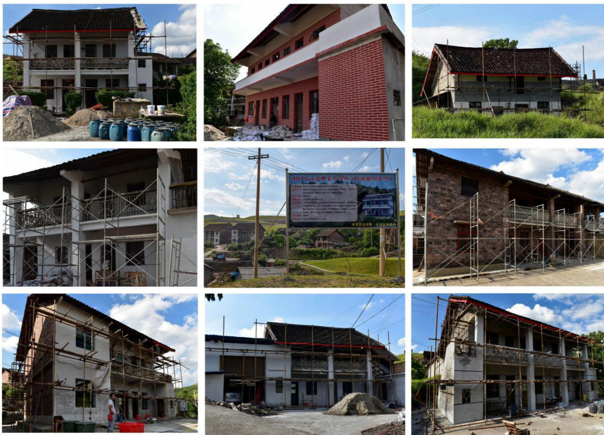
锡矿山地区房屋集中风貌改造
