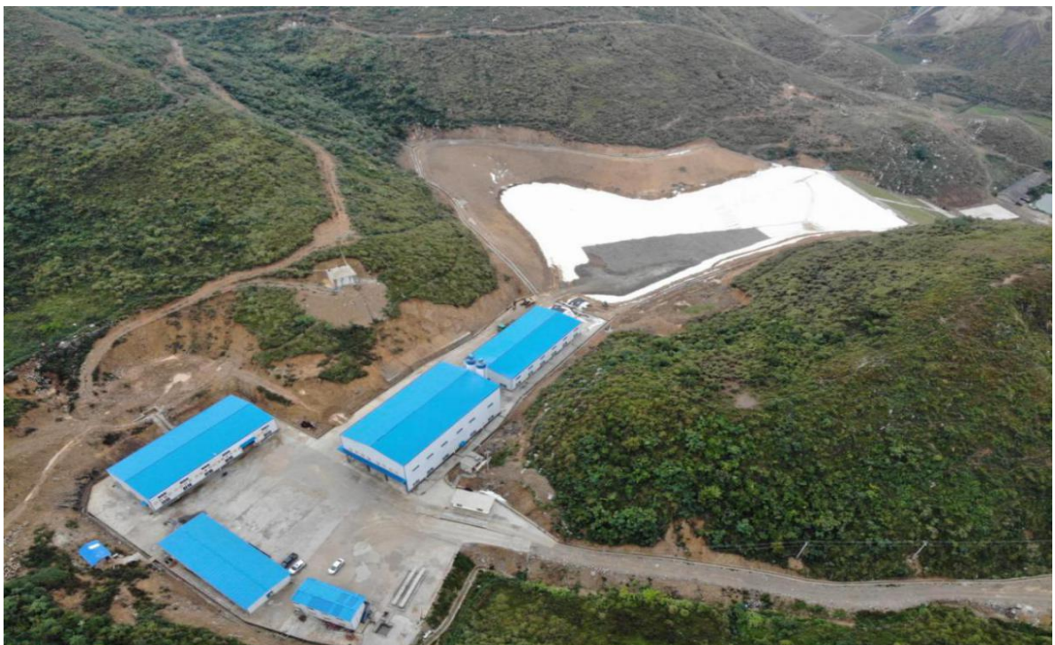
历史遗留砷碱渣（野外混合渣）治理工程
