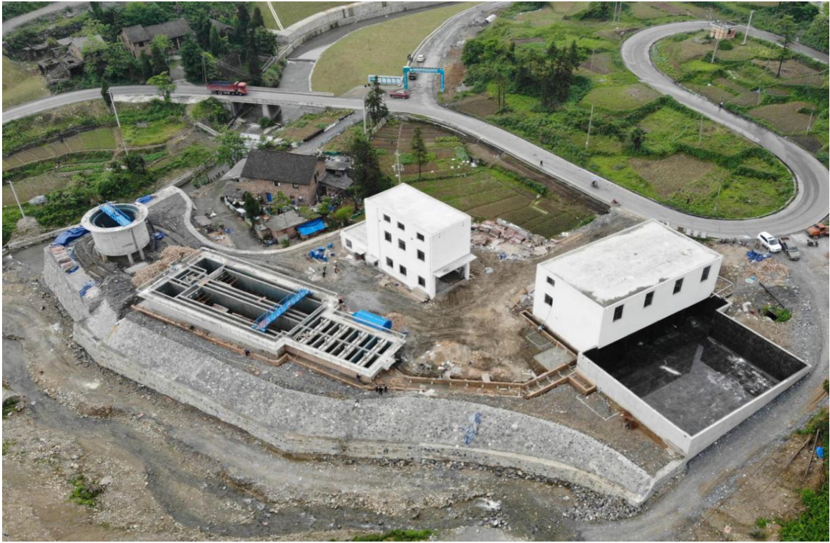
锡矿山北矿区青丰河污水处理厂
